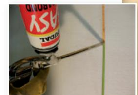
Následné práce a povrchové úpravy jsou možné po 1 hodině. Vytvrzenou přebytečnou hmotu odřeze, nevytvřenou čistěte Soudal čističem PU pěny. Další informace jsou uvedeny v technickém listu.
