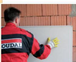
Desku lehce přitiskněte na podklad a nejdéle do 8-mi minut vyrovnejte do požadované polohy (při +20 °C a 65% RH, se zvyšující se teplotou a vlhkostí se čas možnosti korekce zkracuje). Dutiny a spáry mezi deskami vyplňte pěnou **SOUDABOND EASY**.
